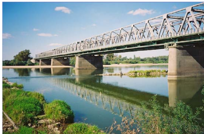
Fot. 2. Widok ogólny mostu drogowo-kolejowego przez Wisłę w Nagnajowie.
