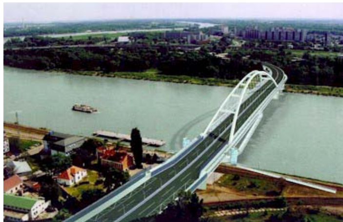
Fot. 2. Gotowy obiekt
