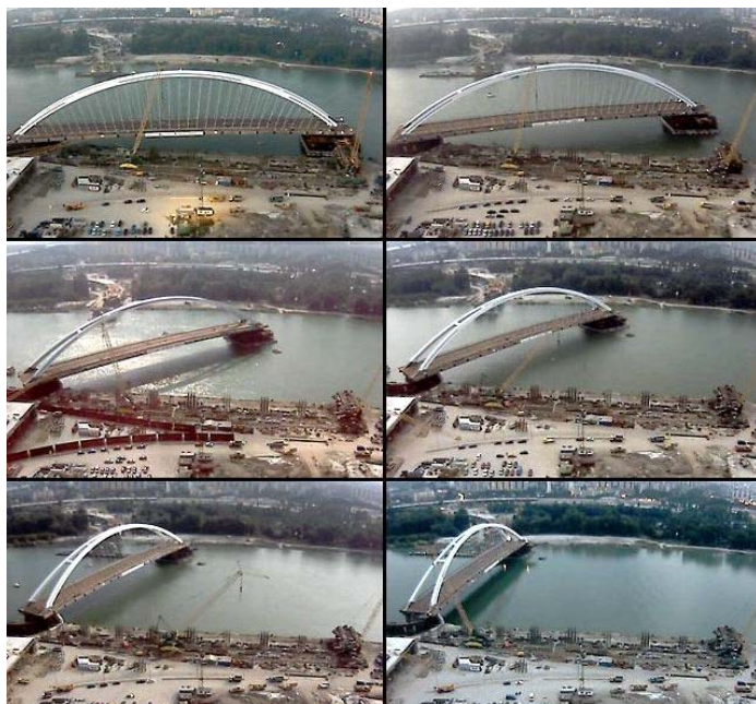
Fot. 1. Obracanie mostu
