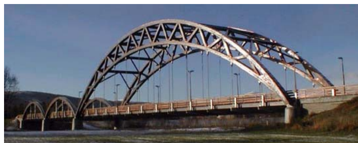
Rys. 2. Widok ogólny mostu
