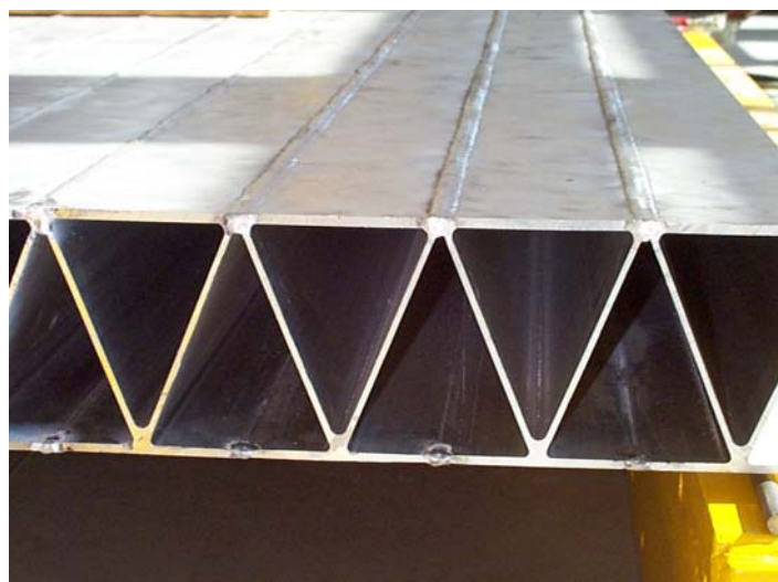
Fot.1. Przekrój poprzeczny pomostu
