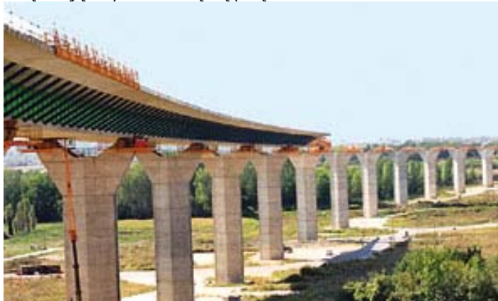
Fot. 3. Widok ogólny obiektu w czasie nasuwania przęsła
